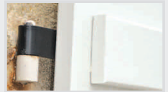
PLIAGE DES PENTURES : adaptation aux gonds existants
