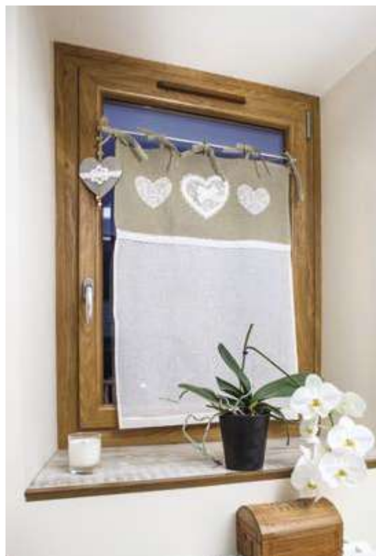
Fenêtre oscillo-battante posée en embrasure. Option ferrage invisible pour limiter l'ouverture pour ces cas de pose.
