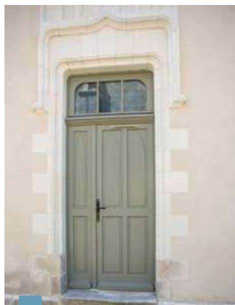
COLORADO tiercé sans moulure grand cadre avec défonçage ogive sur panneau plate bande. Imposte fixe en dormant
