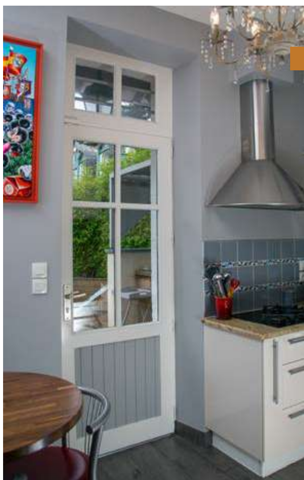
Panneau lames massives et imposte fixe en faux ouvrant
