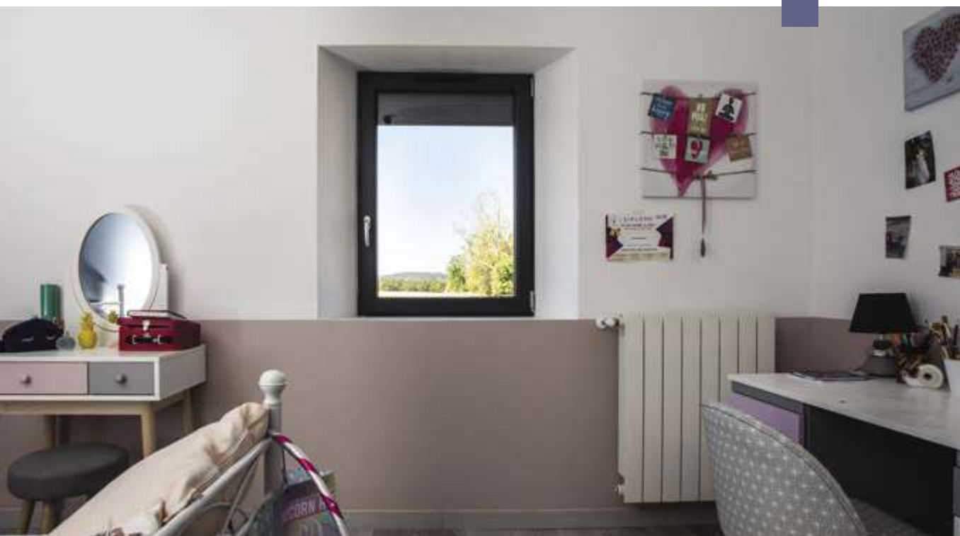
Fenêtre oscillo-battante posée en embrasure. Option ferrage invisible pour limiter l'ouverture pour ces cas de pose.
