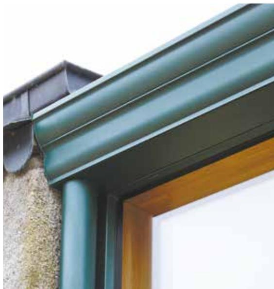
Chéneau aluminium mouluré, avec descente d'eau de pluie (diamètre 80).
